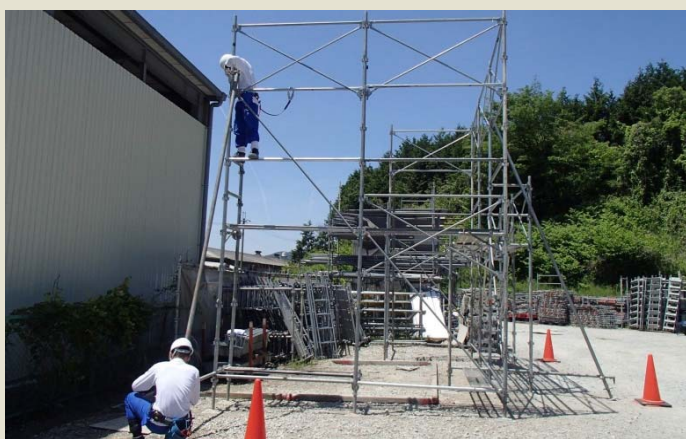
* 倒壊防止…足場が倒れない様、ヤラズを設置
