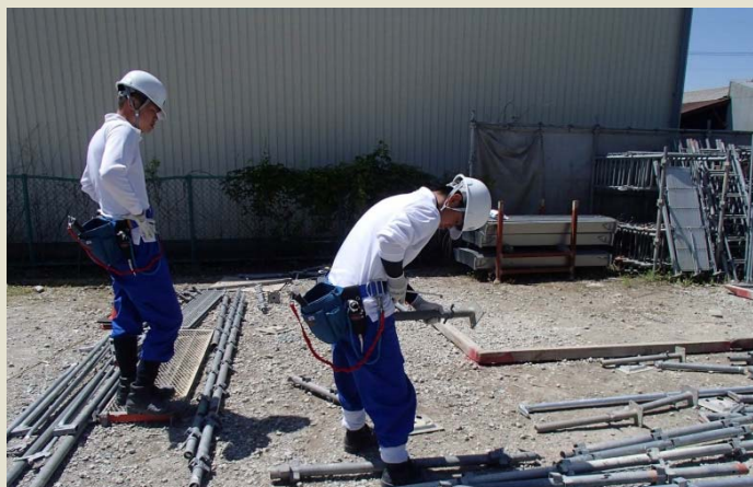
* 足場の組み始め…ジャッキハンドルの高さを設定。
