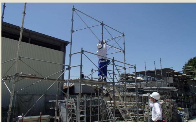
* 足場先行工法…安全な体勢で上層作業が出来る
