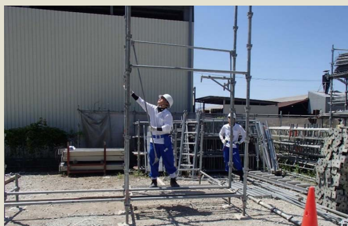
* 足場先行工法…下層の作業床から上層の墜落防止手摺を設置
