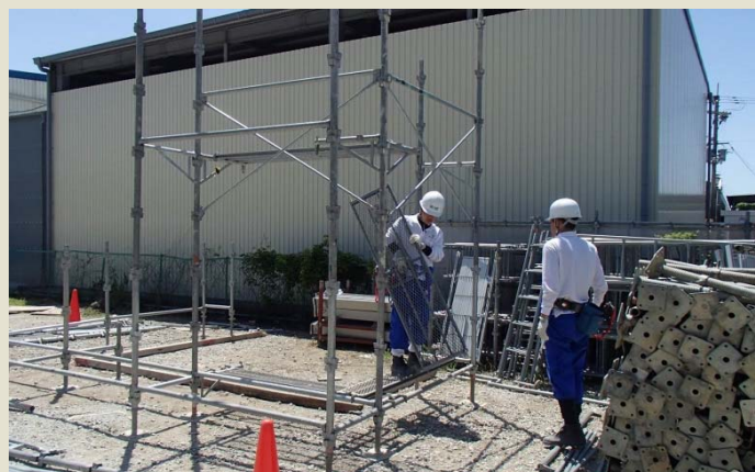
* 上層の作業床設置
